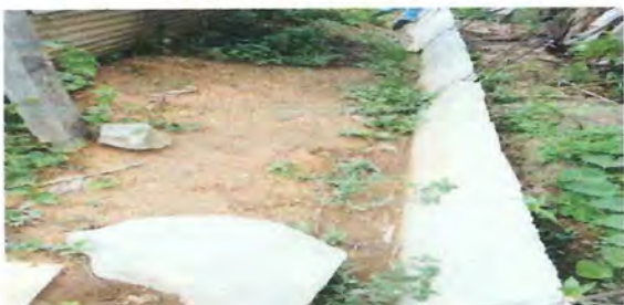
Foto 3: Rehabilitaion de pared de aula 2
