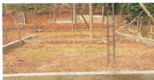
Foto 6: Acabado de pared perimetral de aulas
