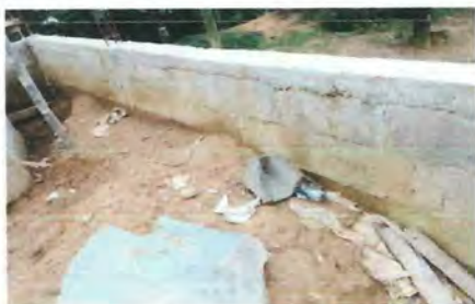
Foto 5: Acadabo de concreto de modulo 2
