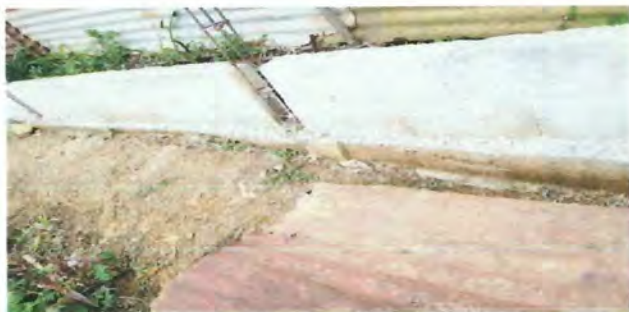
Foto1: Fundiciones de columnas por la comunidad
