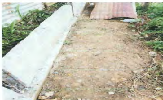
Foto 4: Acabado de simiento de concreto de modulo 1
